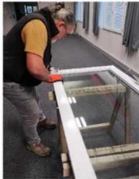
2. Manutention sur espace de démantèlement
