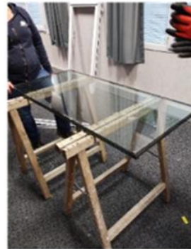
5. Remise en état du vitrage (126x50cm) Pour réemploi in-situ
