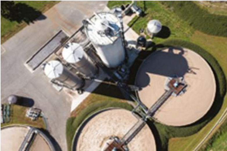
Station d'épuration de Cartonnerie Gondardennes
